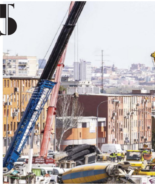
Vista del estado de las obras
