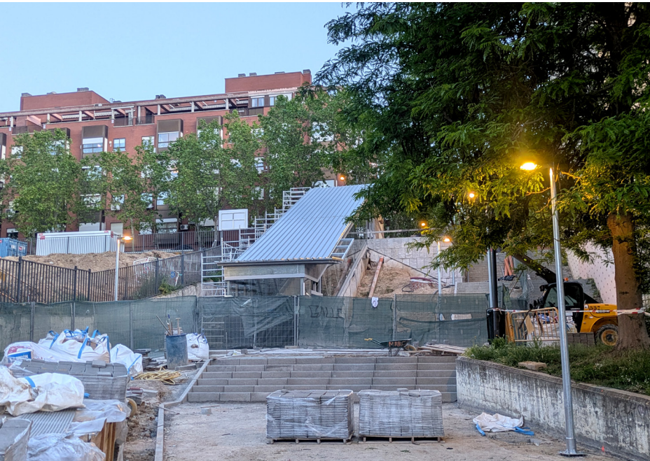
Obras funicular entre calle Sepúlveda y calle de Monsalupé mayo de 2025
