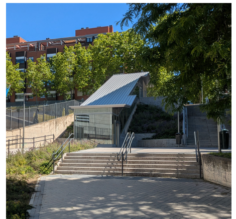
Elevador entre calle Sepúlveda y calle de Monsalupe
