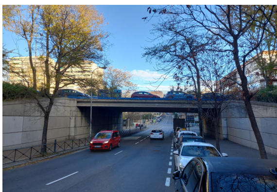
Actual Puente de la calle Sepúlveda
